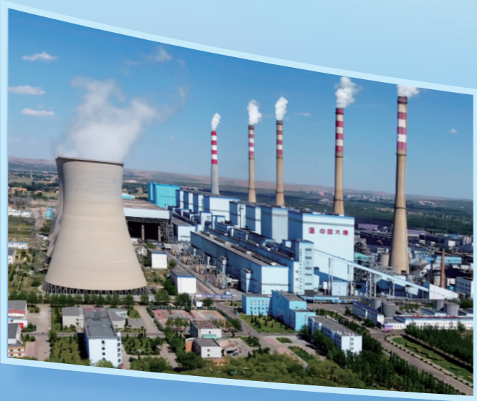
大唐托克托发电厂-世界最大火力发电基地
